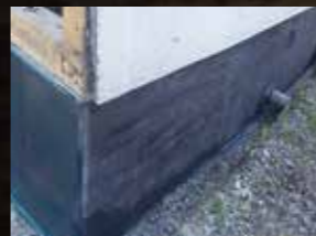
4 炭素繊維シート、貼付け
